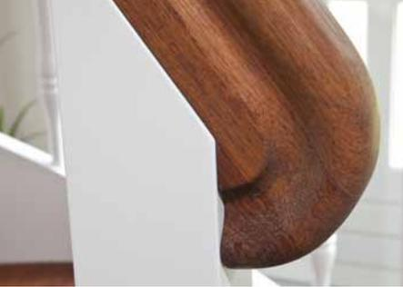
Bogentreppe mit asymmetrischer Blockstufe am Antritt. Beidseitiges, steigend rundes Geländer mit Sonderhandlauf und Handlaufschnecke über Antrittspfosten. Handläufe und Trittstufen in Merbau geölt.
