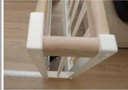
Weisslackierte, ¼ gewendelte Treppe mit Stufen und Handläufe in Esche natur. Kindersicherungsleisten unter den Stufen.
