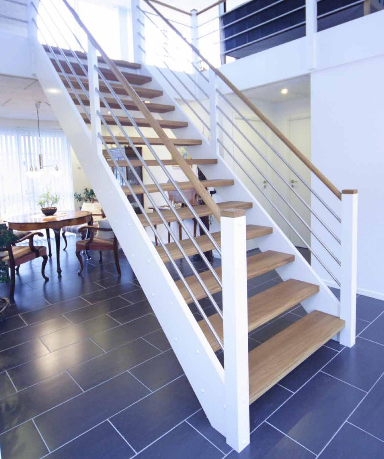
Weisslackierte, gerade Treppe mit Stufen, Handläufe und Pfostenpyramiden in Eiche geölt, mitlaufendes Geländer mit waagerechten Gurten in Edelstahl.
