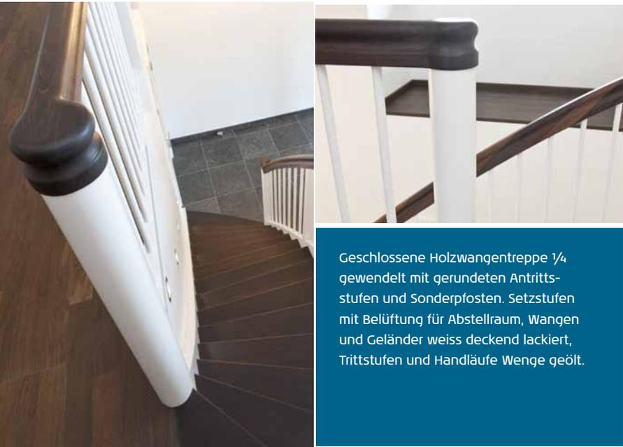
Geschlossene Holzwangentreppe 1/4 gewandelt mit gerundeten Antrittsstufen und Sonderpfosten. Setzstufen mit Belüftung für Abstellraum, Wangen und Geländer weiss deckend lackiert, Trittstufen und Handläufe Wenge geölt.
