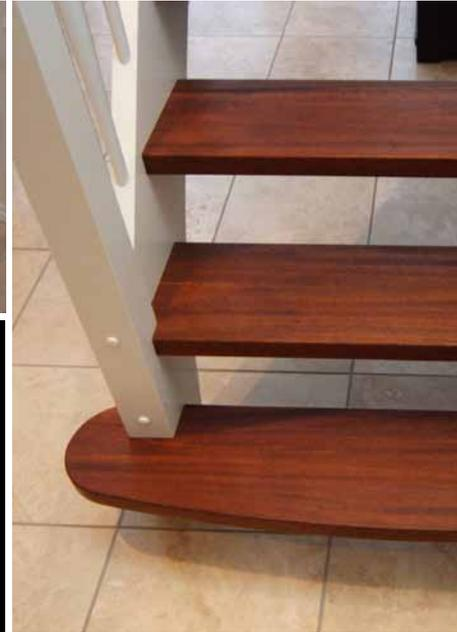
Weisslackierte, ¼ gewendelte Treppe mit Stufen, Handläufe und Pfostenpyramiden in Mahagoni natur, einseitige runde Blockstufe am Antritt.
