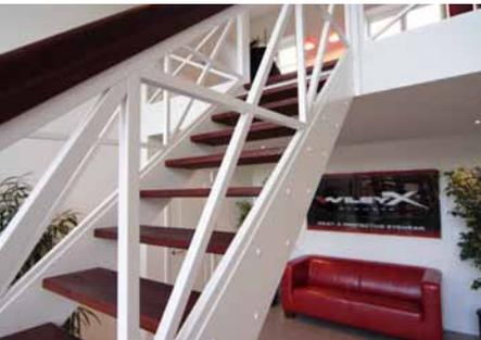
Weisslackierte, gerade Treppe mit Stufen und Handläufe in Jatoba natur. Die Treppe hat ein Sondergeländer mit Kreuzfüllungen und eine zweiseitige Blockstufe am Antritt.
