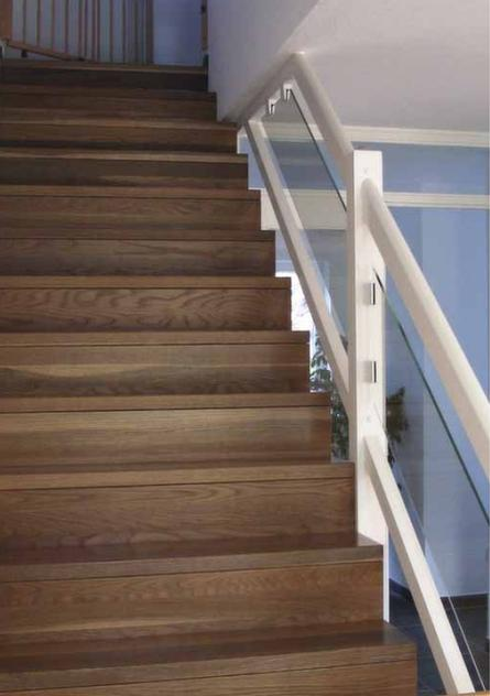
Modernes Falwerk als Stufenbelegung
