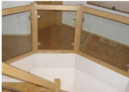
Moderne Treppenanlage in europ. Ahorn natur, schlichtes Geländer mit mitlaufenden Edelstahlgurten, Sondergrundriss mit gebrochenen Aussenecken.
