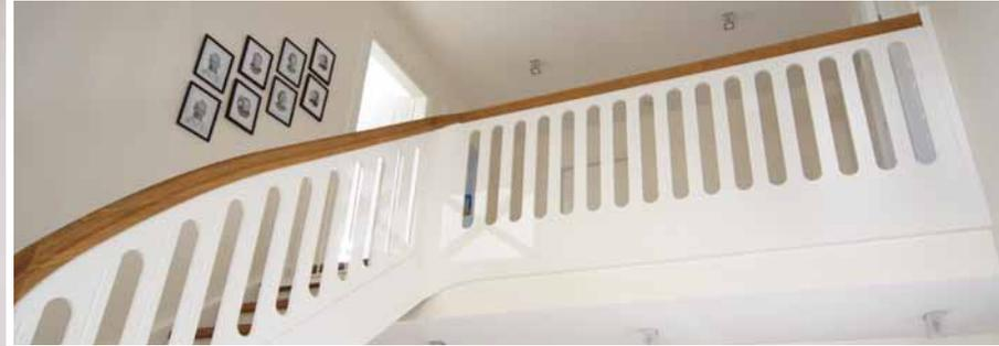
Sonderkonstruktion mit Geländer als ausgefräste Plattenfüllungen, weiss lackiert. Treppe mit Stufen und Handläufe in Eiche geölt. Krümlingspfosten mit aufgesetztem Handlauf im Omegaprofil.
