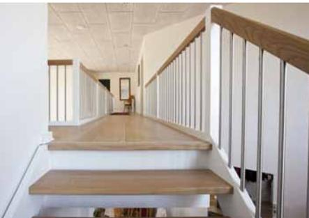
Spezialkonstruktion mit Sonderpodest in Eiche weissgetönt, Wangen und Geländer weiss deckend lackiert, Stäbe Edelstahl.
