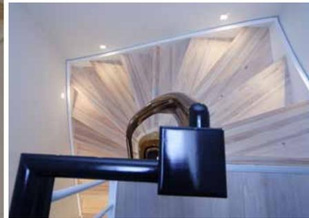
Weisslackierte, 1/2 gewendelte Treppe mit Stufen in Kiefer gewachst und schwarz lackiertem Handlauf. Handlauf und Lichtwange steigend rund, Treppe geschlossen mit Setzstufen.
