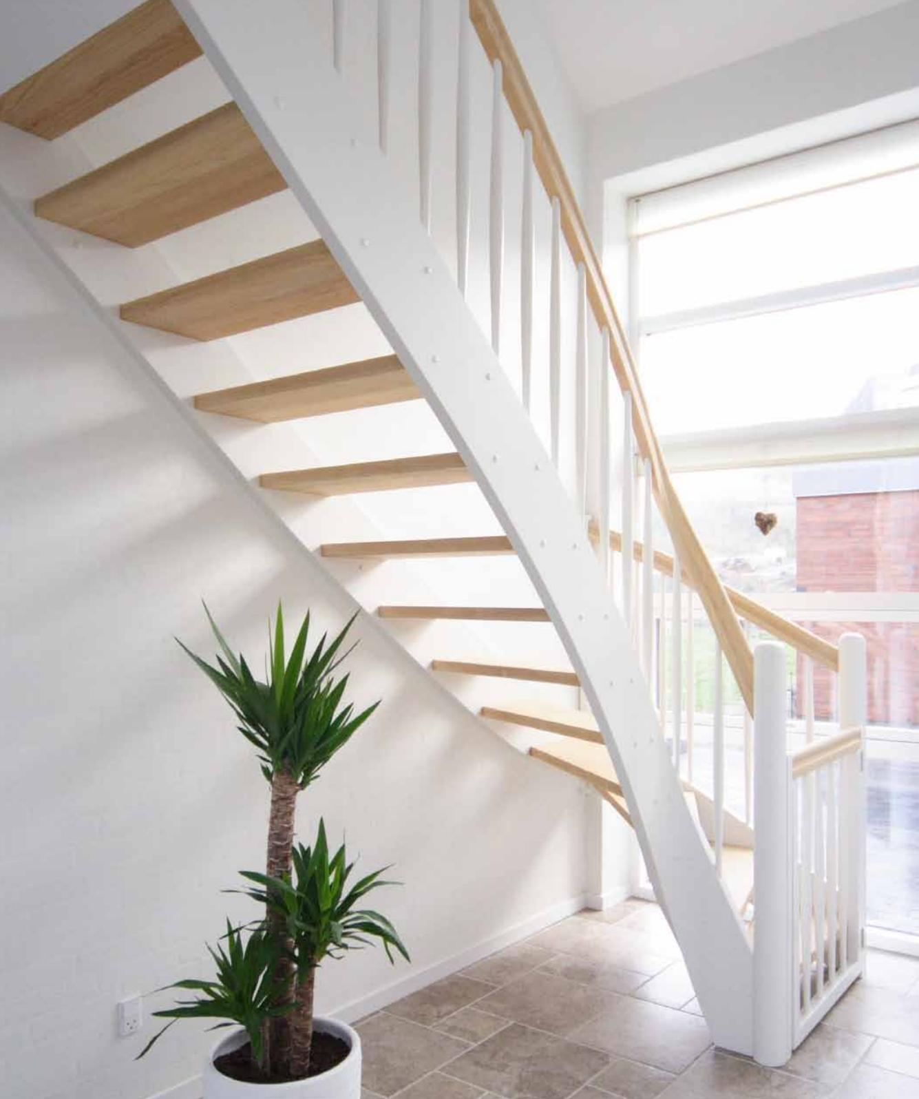
Weisslackierte, ¼ gewendelte Treppe mit Stufen und Handläufe in Esche natur. Steigend rundes Geländer im Treppenauge, passende Kinderschutztüren an An- und Austritt.
